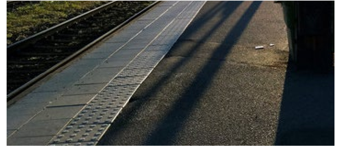
Kupolplattor på tågstationen i Köping. Taktila plattor används ofta i trafiksituationer där det är extra viktigt med tydlighet.
